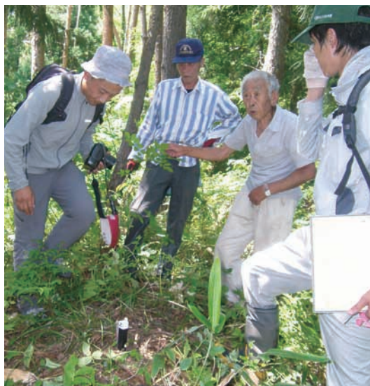
所有者立会いのもと、境界杭を設置
